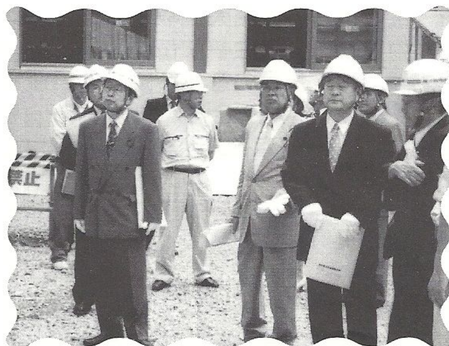
花輪高校改築中の現場視察
